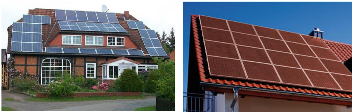
Abb. 97 Negativbeispiel (links): weder farblich noch funktional abgestimmte Anlage und Positivbeispiel (rechts): farblich angepasste Aufdach-Anlage mit ruhigem Gesamterscheinungsbild
