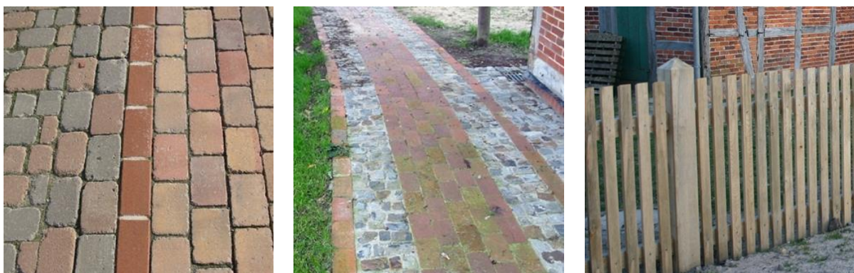
Abb. 98 Beispiele: gerumpeltes Betonrechteckpflaster, Naturstein/Klinker, Holz-Staketenzaun
