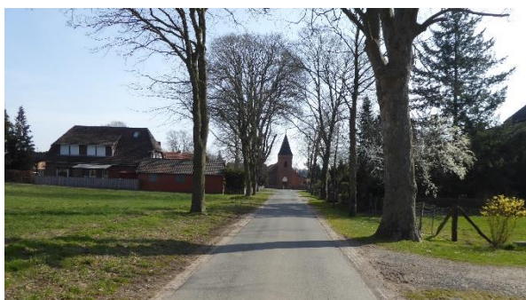
Blick von Westen auf die Kapelle
