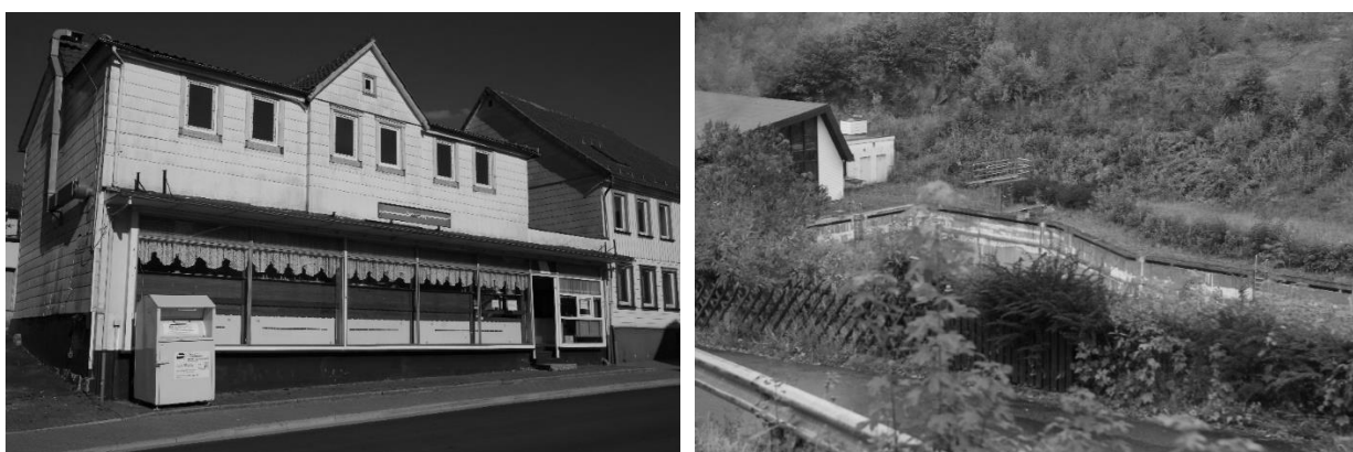
Abb. 18 Beispiel Leerstand und geschlossenes Freibad
