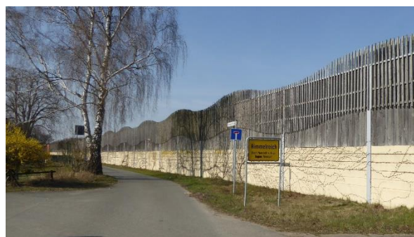
Himmelreich, Lärmschutz entlang der B6
