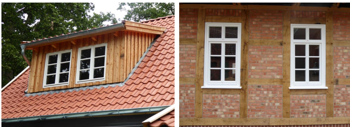
Abb. 95 Beispiele: Neue Dachgaube mit Fenstern und Holzverschalung, erneuerte Fachwerkfassade
