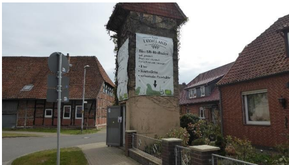
Empede, Selbstversorgung im alten Trafoturm
