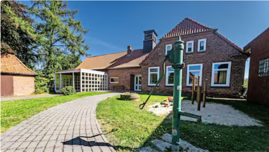
Eine Baustelle der Zukunft: Das Dorfgemeinschaftshaus in Bevensen. Quelle: Mirko Bartels
